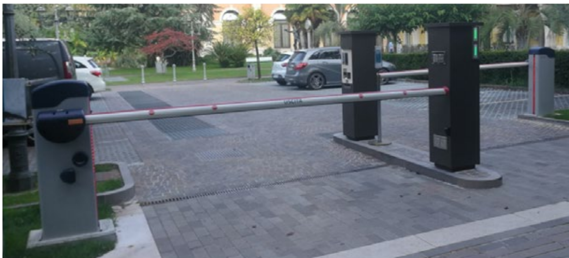
Sbarre (barriere) automatiche alimentate a energia elettrica di 5 m per accesso / di 5 m per uscita
